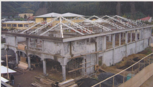
Gimnasio-auditorio, en construcción.
