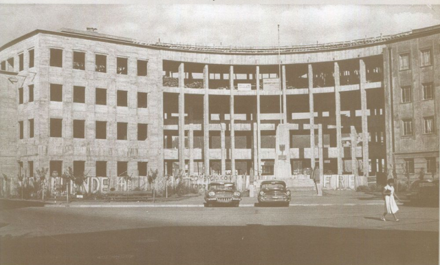
Edificio de los Tribunales de Justicia, aún en construcción.
