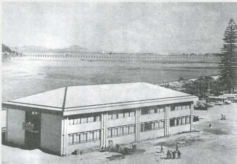
Primer edificio definitivo del Colegio Concepción Pedro de Valdivia, 1987.
