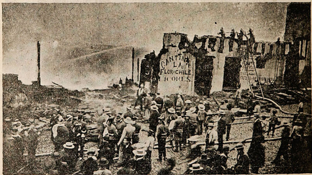
LOS BOMBEROS APAGANDO LOS ESCOMBROS.
