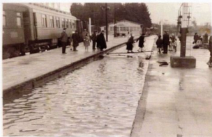
Inundación de los andenes en la estación de Renaco.
