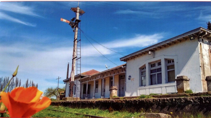
Estación ferroviaria Renaico Fotografía Cristian Rodríguez Domínguez Año 2020.
