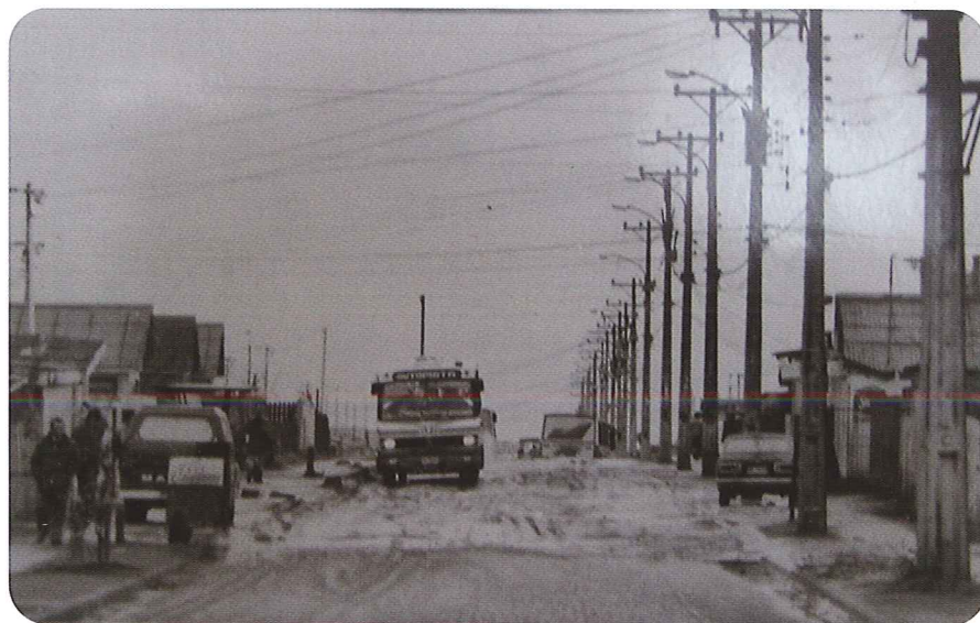
Calle principal del barrio antes de ser pavimentada.
