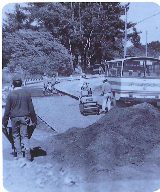
Inicio pavimentación del acceso al barrio.
