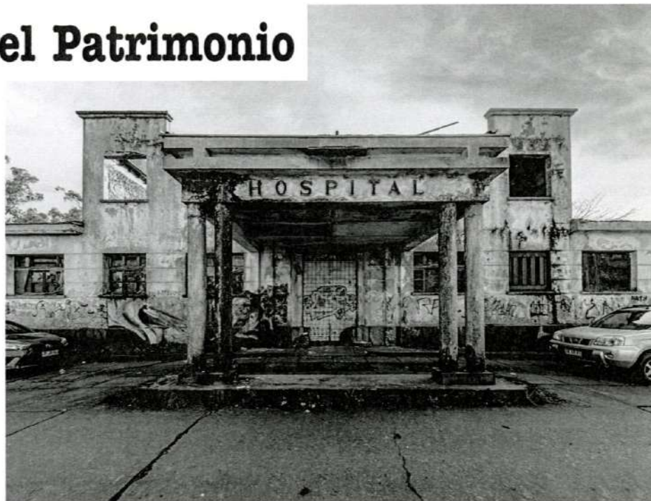
Antiguo edificio del Hospital de Lota
