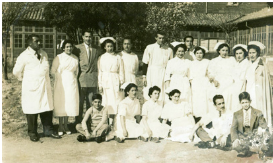
El Hospital San Juan de Dios (aquí con parte de su dotación funcionaria) colapsó en el terremoto del año 1939.
