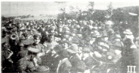
Durante la bendición de la primera piedra.
