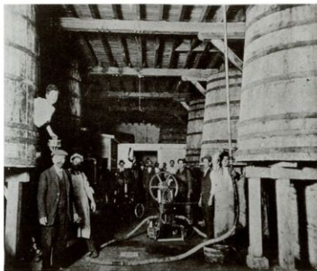
Bodega de la zona central.
