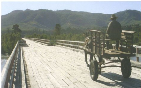
Puente de Sipas sobre el río Itata.
