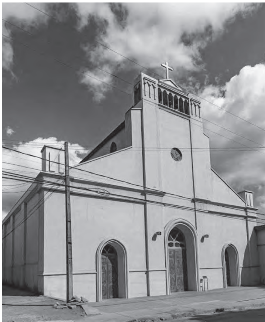
Parroquia San Ambrosio de Chanco. Demolida por los daños ocasionados a raíz del terremoto del 27 de febrero de 2010, fue reconstruida e inaugurada el 24 de enero de 2020, como se aprecia en la imagen.
