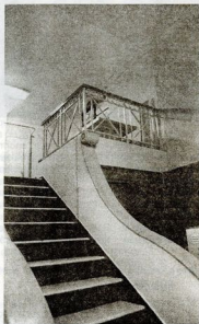
Detalle escalera. Cine Cervantes (32)
