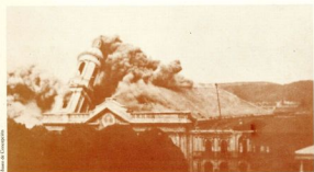
La segunda torre de la Catedral cae luego de declararse irreparable el edificio.
