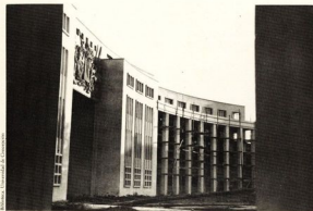
Construcción del Campus de la Universidad de Concepción.
