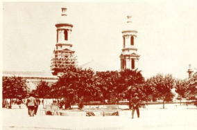
La Catedral de Concepción durante la construcción de sus torres, a inicio de siglo.
