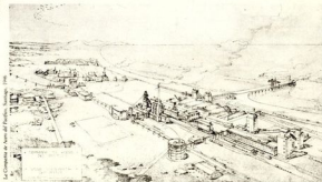
Proyecto original de la planta siderúrgica de Huachipato.
