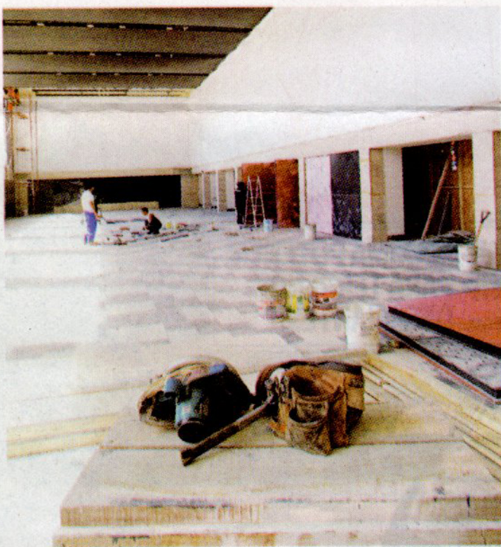
Las obras que se realizan actualmente en el salón.
