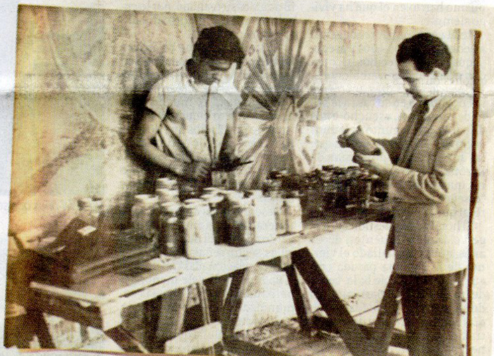
Uno de los estucadores que trabajó en la obra. A la derecha, el pintor.
