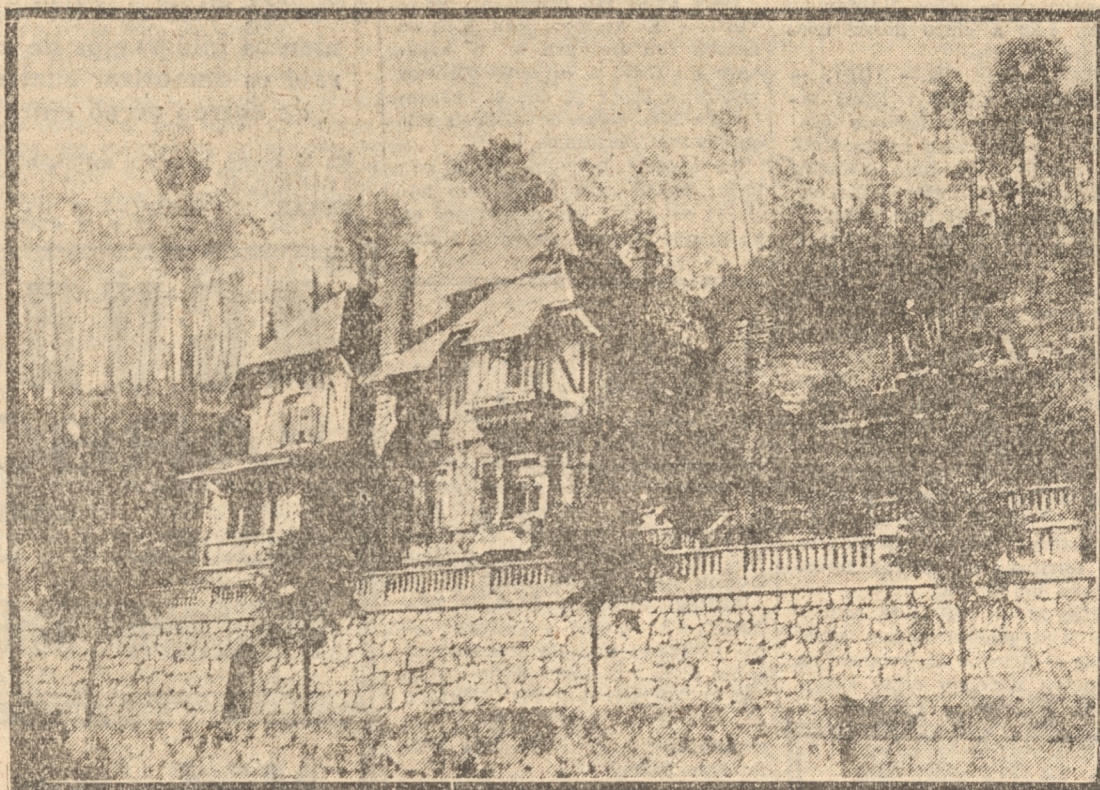
CHALET DE PROPIEDAD DEL DR. DON OTMAR WILHELM QUE FUERA DE LOS DETERIORES QUE LE CAUSO EL TORNADO MISMO, DECIBIO LOS IMPACTOS CAUSADOS POR LAS VIGAS DEL EDIFICIO DE LA FABRICA DE CALZADO QUE PERFORARON EL TECHO
