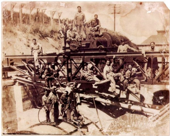
"PERSONAL TÉCNICO QUE CONSTRUYE EL VENTILADOR GIGANTE"
